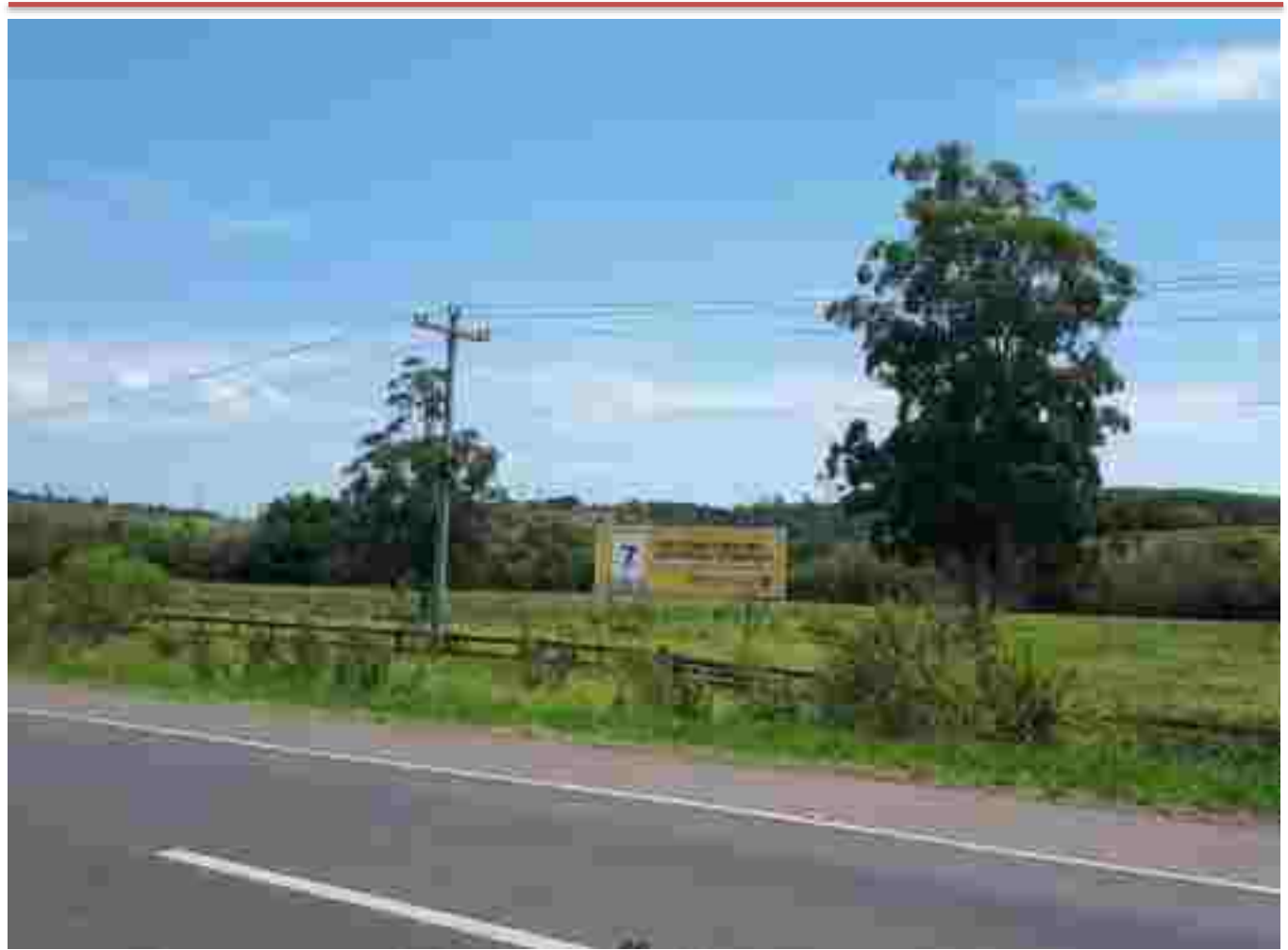
Local: 11511 BR 116 (N) chegada NH - frente Renosulbra - F. NH
